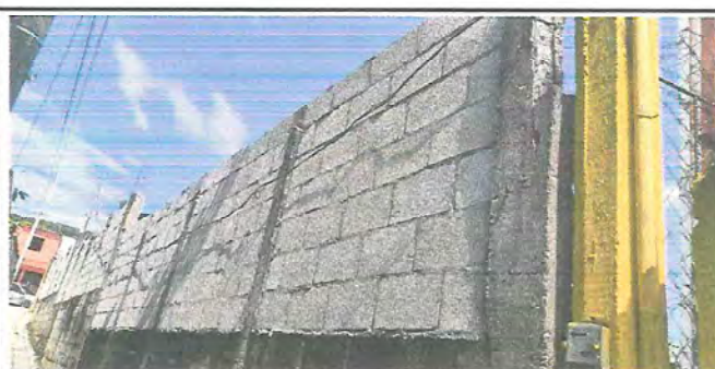
Foto 6: Reparación de muro perimetral
