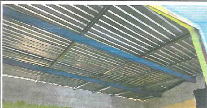
Foto 3: Sustitución de estructura metal por metal
