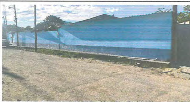
Foto 4: Reparación y repello de muro perimetral
