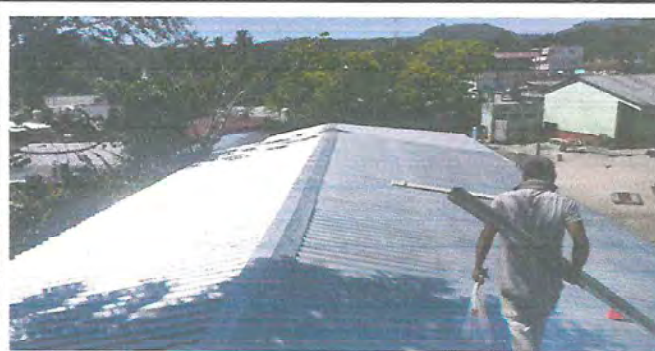
Foto 2: Sustitución de lamina acanalada por lamina troquelada
