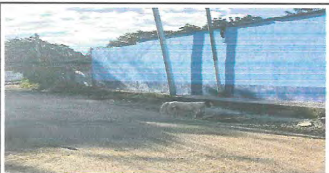
Foto 5: Reparación y repello de muro perimetral
